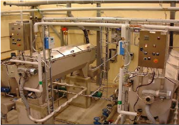
소화조 이전에 설치된 두개의 드럼 농축기 Siljan RotoMaster SF 17
