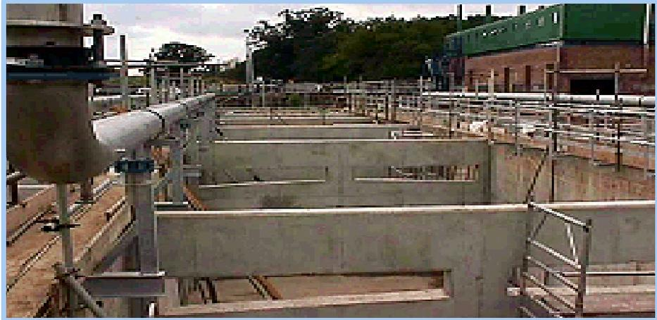
MBBR 시스템으로서 질소제거를 위해 영국내 최초로 적용된 플랜트로 처리시설 면적은 매우 제한되어져 있고 총 질소제거를 위해 시설을 보수해야만 하는 상황이었다. 이러한 새로운 요구를 기존의 반응조를 7개의 각각의 조로 나누어 MBBR 프로세스를 적용시킴으로서 해결하였다. 이 보수공사는 새로운 1차 침전조와 MBBR프로세스를 설치하기 위해 기존의 스크린과 저장조등을 보수하는것등을 포함하였다.
