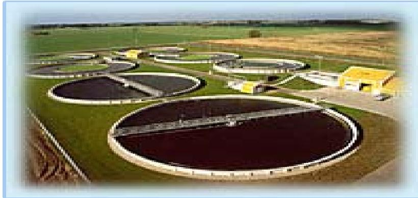
덴마크 Ringsted에 위치한 150,000상당의 하수처리장은 덴마크 최대의 도축장에서의 산업폐수와 도시하수를 함께 처리한다. 공사는 turn-key 방식이었고 완공년도는 1993년이 었다. 생물학적 질소와 인의 제거를 위해 설계되어진 이 프로세스는 혐기, 전-탈질화과 질산화과정으로 되어 있다. 연속적인 물과 슬러지의 순환이 고도 영양염류처리를 가능케 한다. 반송 슬러지는 혐기조에 유입되기 전에 탈질화 된다. 2차처리에서의 모든 원형조는 미리 주조된 콘크리트 유니트로 되어 있다.
